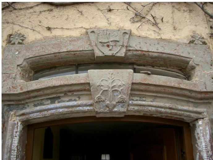
Clef de voûte: 1753
