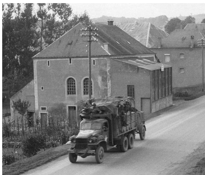
Vue de la maison et de l'atelier de serrurerie Hottua en septembre 1944 Photo: General Patton Memorial Museum, Ettelbruck, Romain Reinard
